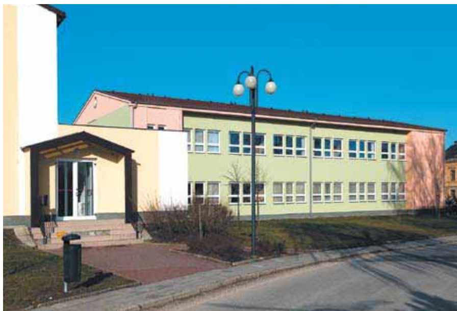
Budova 3 po zateplení
