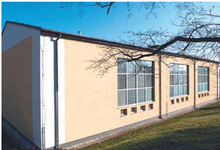
Budova 4 po zateplení
