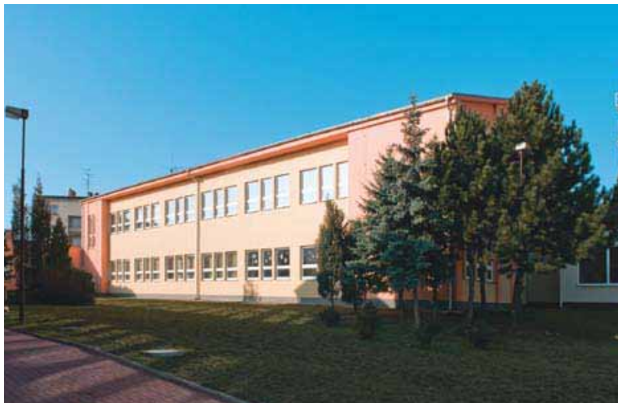
Budova 2 po zateplení
